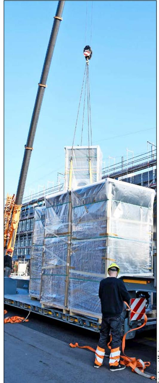
Der Kran hebt das erste der vier transportierten Lüftungselemente an.
