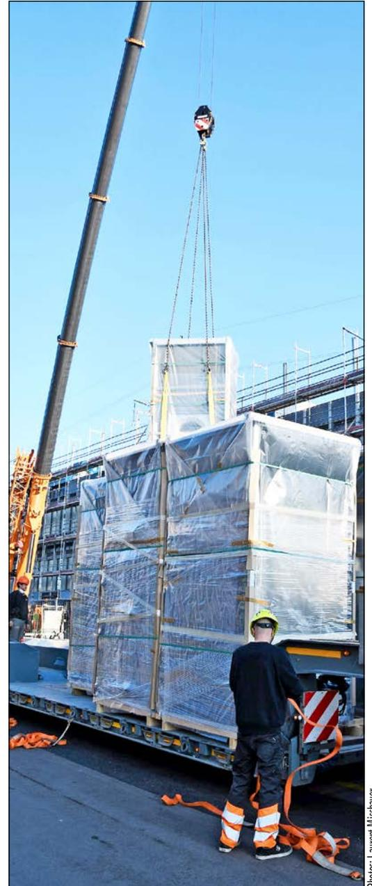
*La grue hisse sur le toit de l'immeuble le premier des quatre éléments du système de ventilation.*
