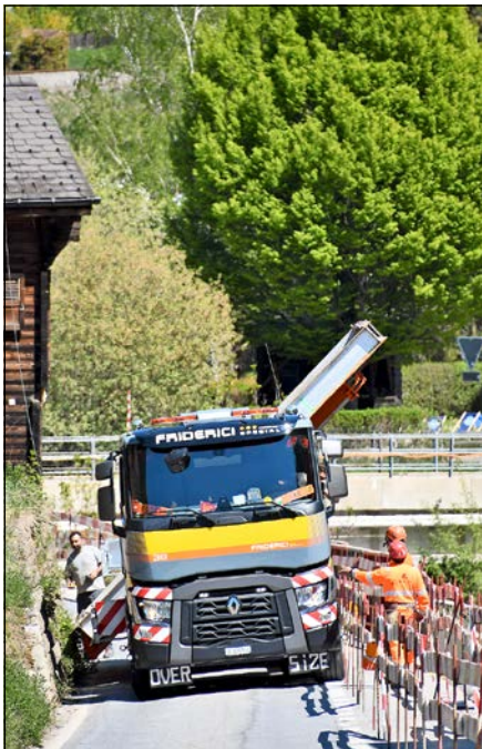
Le passage le plus difficile à Mörel: il a en effet fallu démonter les barrières du chantier.
