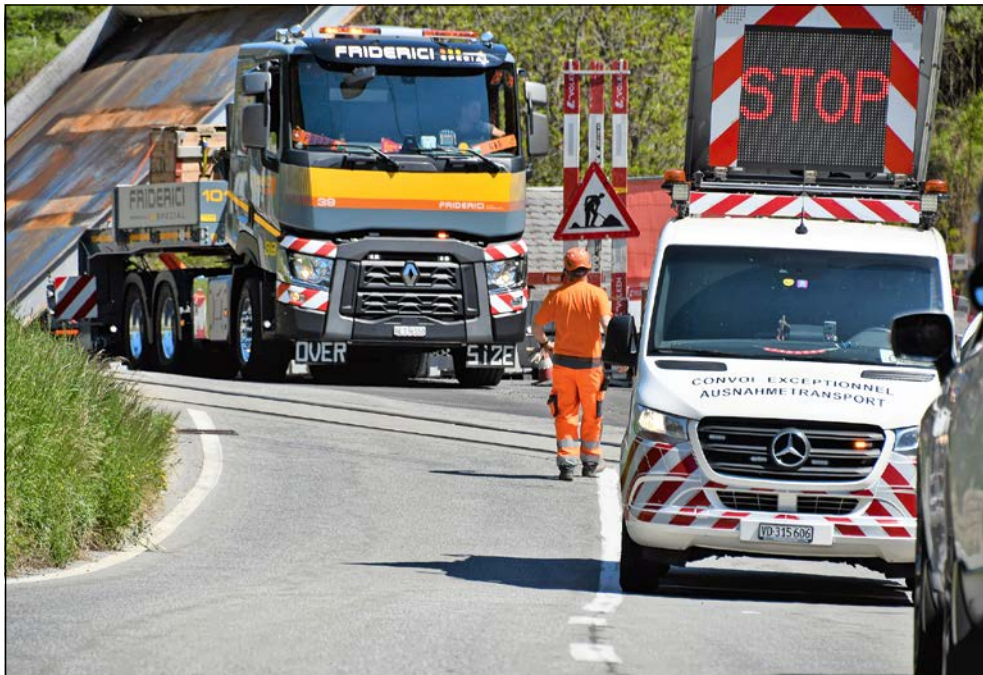
Le franchissement de la voie ferrée à Mörel a lui aussi été compliqué. Les supports où était déposé le bac avaient cependant été inclinés en tenant compte de l'irrégularité de la chaussée à cet endroit.
