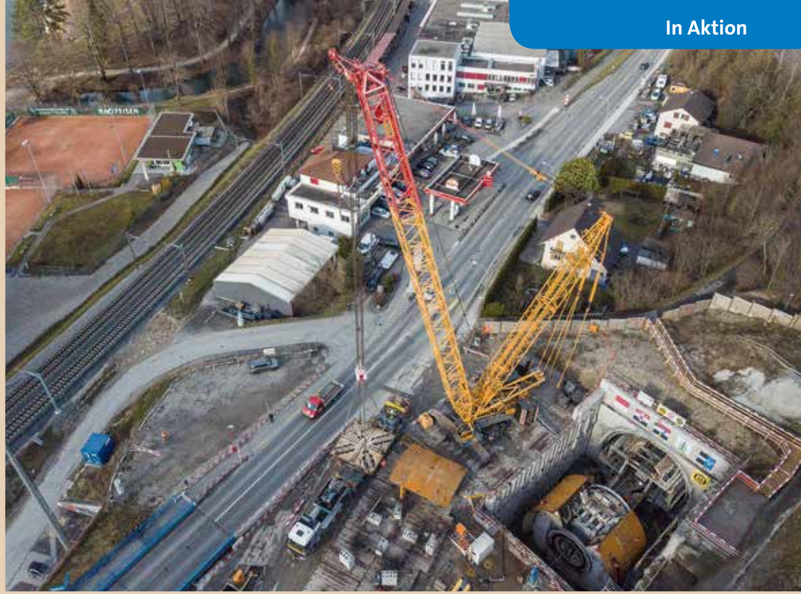
Das Schneiradzentrüm ist auf dem Tiefflader, ein Schildsegment wurde bereits demontiert. Der Rest des Bohrkopfes ist noch in der Baugrube.
